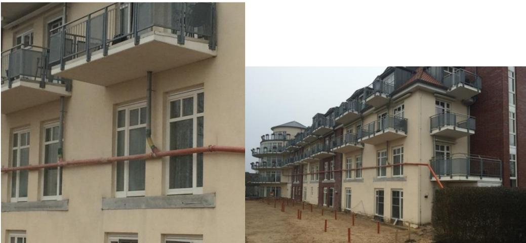
Abhilfe schaffen hier z.B. bei Balkonen statische Sonderanfertigungen oder spezielle Isolierkörbe. Ein Produktbeispiel für die Wärmebrückenvermeidung bei Balkonplatten zeigt folgende Abbildung.
