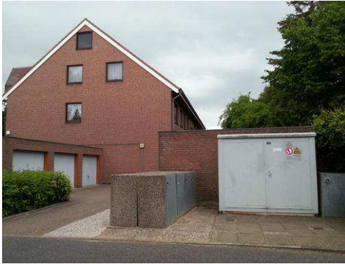
Bebauung nordwestlich der Heinrichstraße
